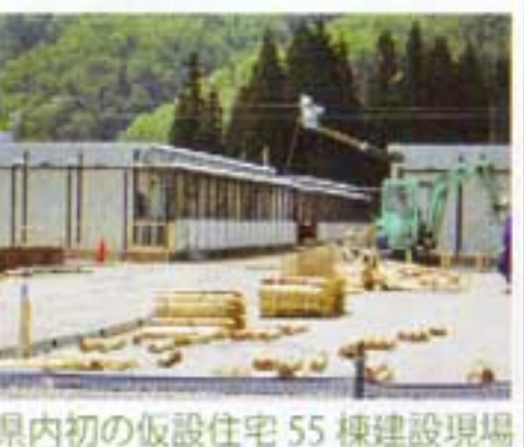
県内初の仮設住宅 55 棟建設現場
