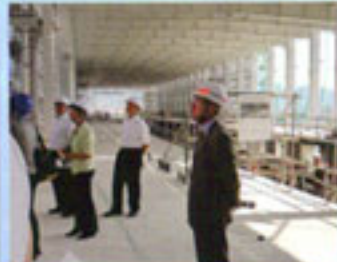
5.31 総務企画委員会現地調査 新幹線工事
